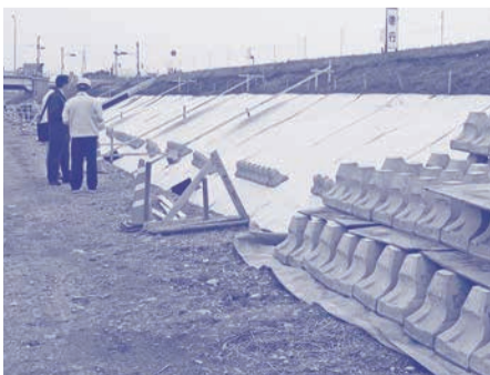
重信川の出合大橋付近漏水箇所の復旧工事を視察
